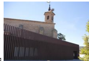
ALBERGUE MUNICIPAL "SERVANDO ARGAIZ" Calle La Iglesia
